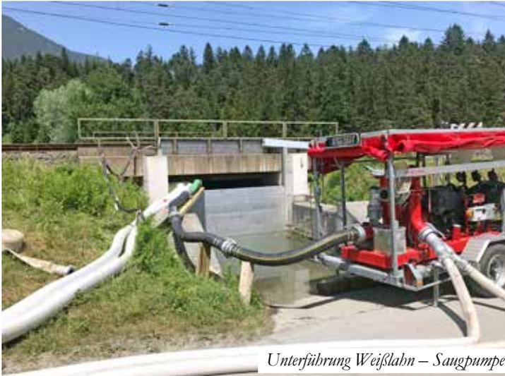
Unterführung Weißlahn – Saugpumpen beim Senken des Grundwasserspiegels
