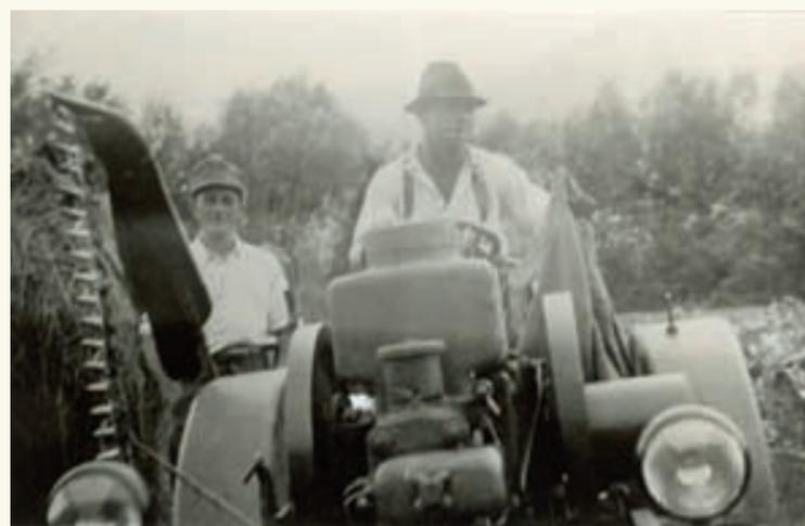
Das war der legendäre „Kramer-Traktor“ des Eiringerbauern Franz Köchler. Dieser Traktor wurde 1939 gekauft und war der erste in Terfens. Das Fahrzeug hatte einen 11 PS starken Dieselmotor und wurde mittels einer Kette angetrieben. Der Traktor leistete bis zum Jahr 1959 gute Dienste.
