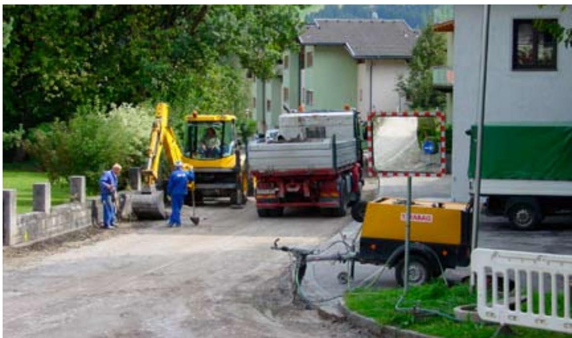
Der gesamte Asphalt wurde abgetragen, da er in einem sehr schlechten Zustand war. Es wird eine neue Tragschicht von 8 cm aufgebracht.
