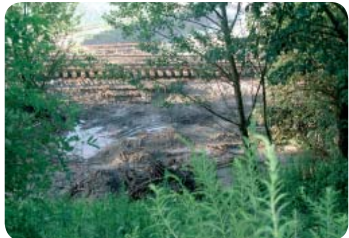
Bereich Bahn, das Kanalrohr unter der Bahn war sofort verlegt und das Wasser suchte sich den Weg über die Gleise bzw. in Richtung Weißlahn; die Gleiskörper waren mit Ästen, Baumstößen und Schlamm bedeckt; das Gleis Richtung Innsbruck war vollkommen unterspült und musste gesperrt werden; durch sofortiges Handeln der Feuerwehr wurde der nächst kommende Zug über Funk gestoppt und ev. Schlimmeres verhindert.
