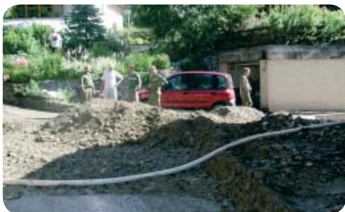
Bereich Waldhof Aufräumarbeiten inkl. Kanäle freimachen
